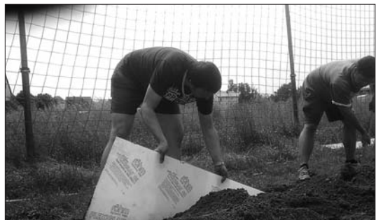
Das verlegen der Platten
