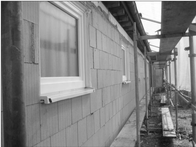
Die schon fertig gemauerte Außenwand mit neuen Fenstern.
