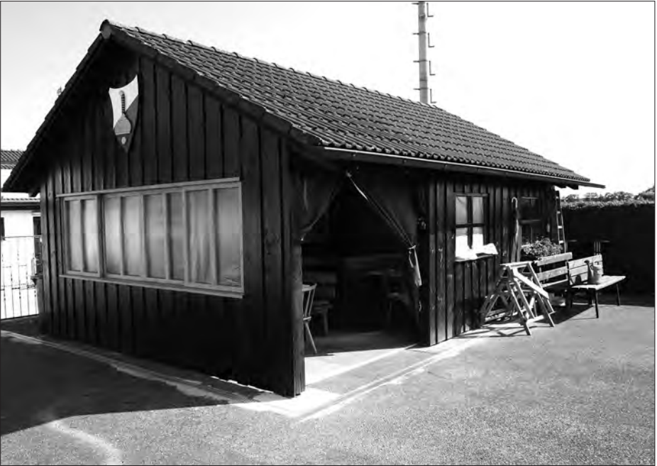
Die neu renovierte Stockhütte.
